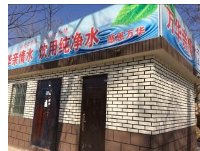
万华援建的居民饮用水处理站
